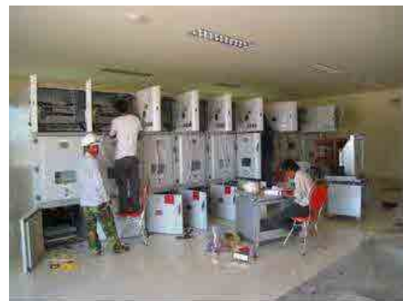
図 9 スイッチギヤ設置の様子
