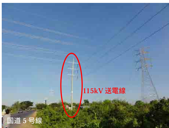
図 5 国道 5 号線横断箇所
