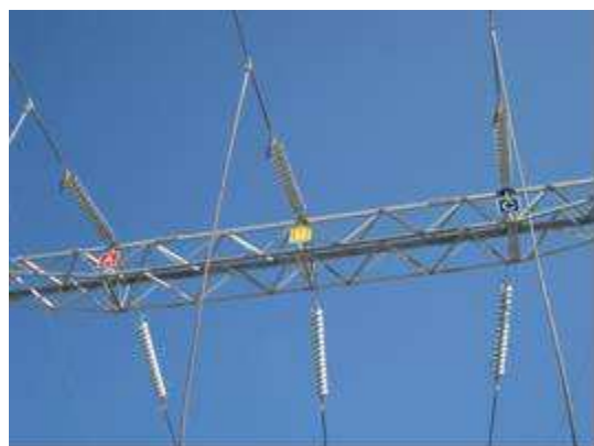
図2 変電所鉄構・機器への相表示
