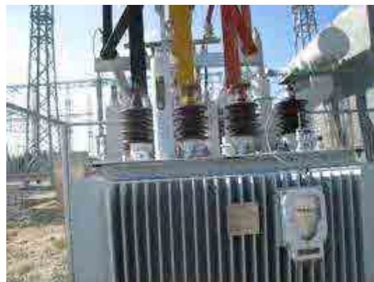
図2 変電所鉄構・機器への相表示
