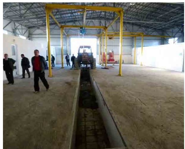
6. 同リペアショップ内のピットとクレーン
