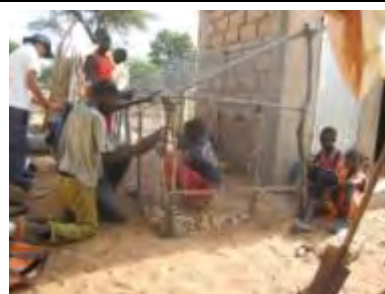
Photo 2 : la 3 ème version du poulailler a une hauteur élevée satisfaisante avec la pente raide. Le poulailler est moins sujet à l'effondrement sous le poids de la pluie.
