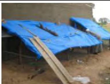
Photo 1 : la première version du poulailler est de basse hauteur et manque de résistance à cause des matériaux à bas prix utilisés
