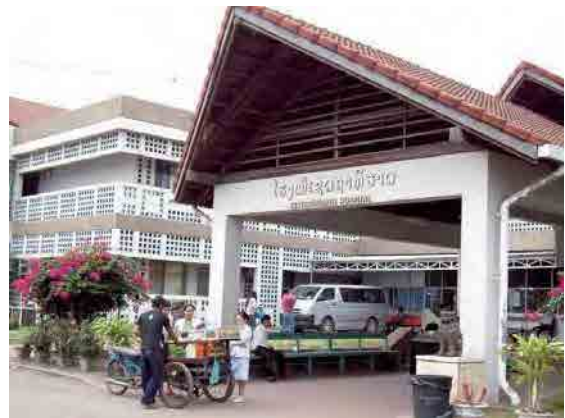
セタティラート病院外観
