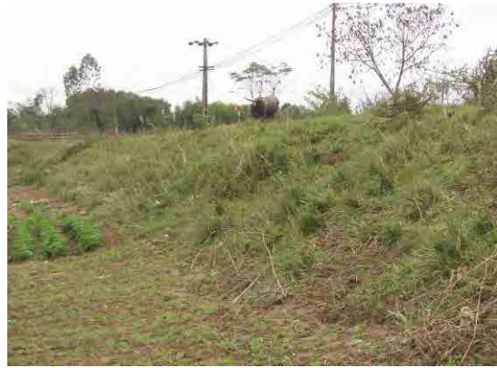
Cỏ mọc tươi tốt trên mái kè
