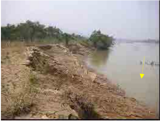
Trước khi thi công
