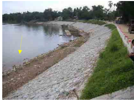
Công trình hoàn thành (hướng hạ nguồn)
