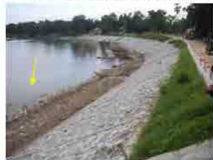
下流より見た河岸侵食対策施設全景
