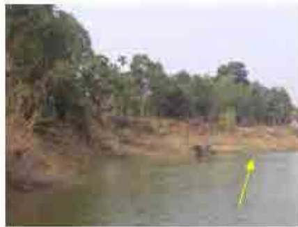
工事前の河岸状況
