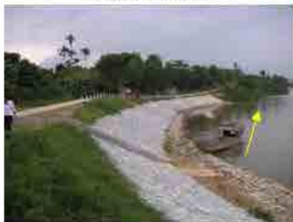
上流より中程地点から見た河岸侵食対策施設
