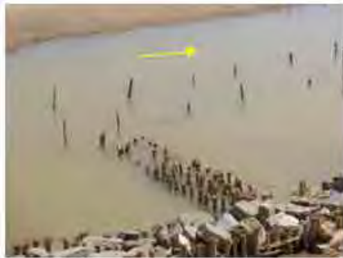
竹による杭出し水制と円筒型蛇籠
