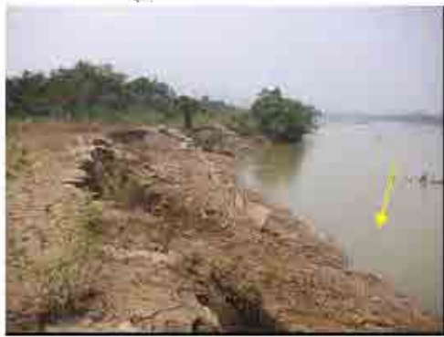
工事前の河岸状況
