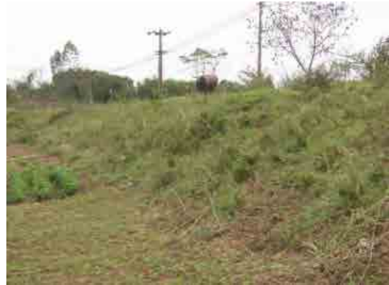
安定度を増した斜面部分
