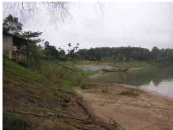
上流側からの全体状況
