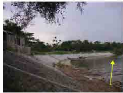
上流から見た河岸侵食対策施設全景
