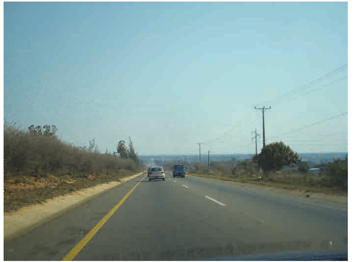
国道1号線 (N1) 道路概況 (舗装済み)
