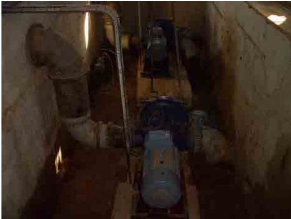
更新された Aliab 灌漑スキームの電動ポンプ
