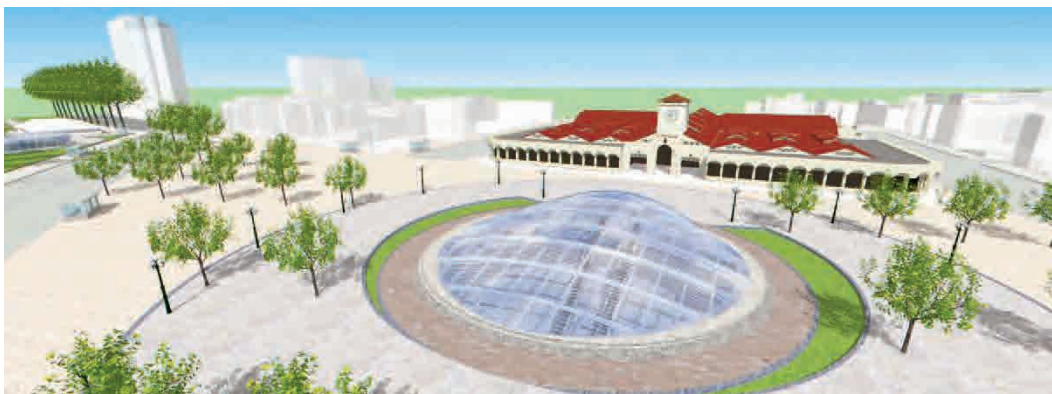
(d) Atrium (H=3.5m, Arch Shape)
