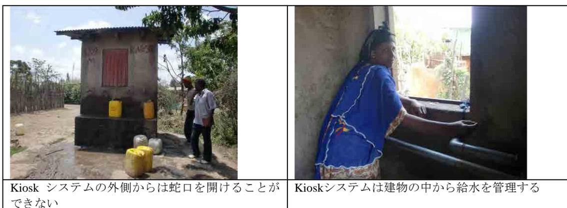
図 9.5: 水栓付有人小屋給水システム“Kiosk システム”
