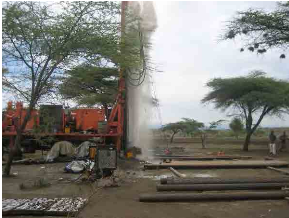
観測井掘削 (1) No.9N 掘削地点
