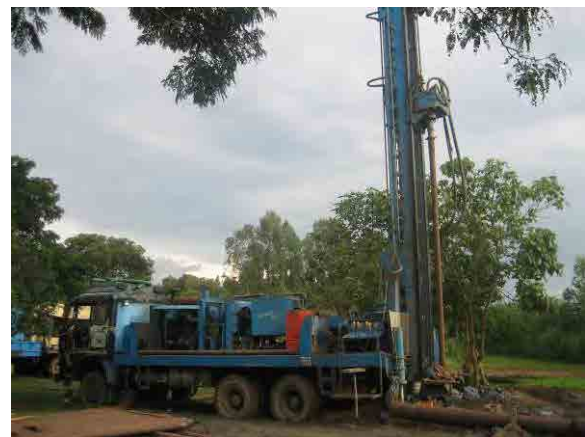
観測井掘削 (2) No.4 掘削地点
