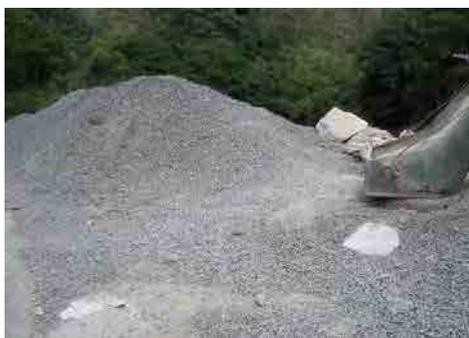
写真-骨材保管状況 整理がされていない
