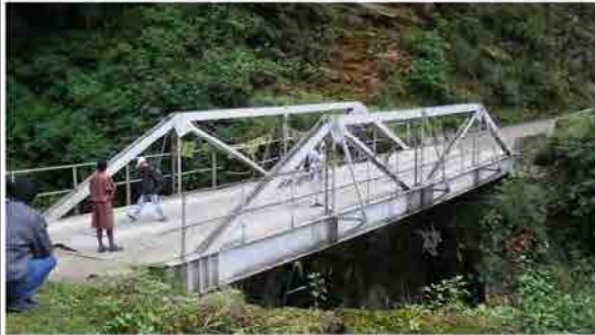
写真 11：ゾンカチュラム橋の全景
