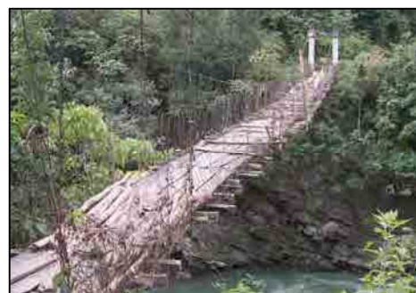
写真-既設人道橋
