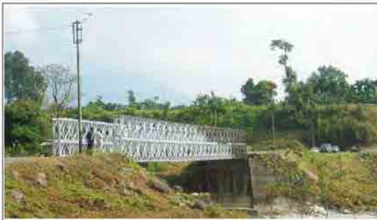
写真1: ドルコラ橋の全景
