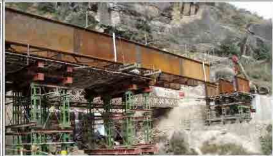
写真 16：ラワカー橋・本プロジェクトの設計に反映するため、第三次計画の橋梁の状況を調査した。
