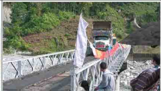
写真4: ジグミリング橋 徐行しながらのトラック渡橋状況
