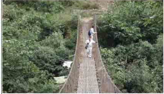
写真 10：ジャンビ橋 床版は鋼製。幅員は非常に狭い。
