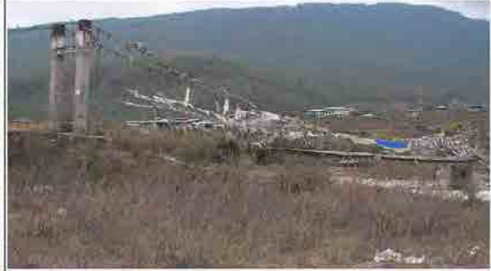
写真 12：ツェンドナ橋の全景。
