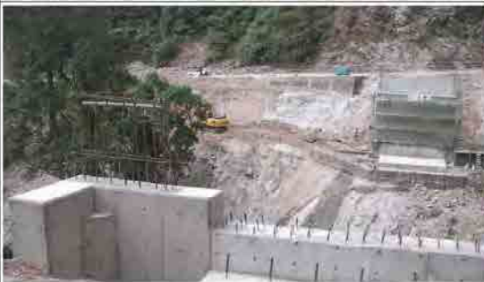
写真 15：ローリン橋・本プロジェクトの設計に反映するため、第三次計画の橋梁の状況を調査した。
