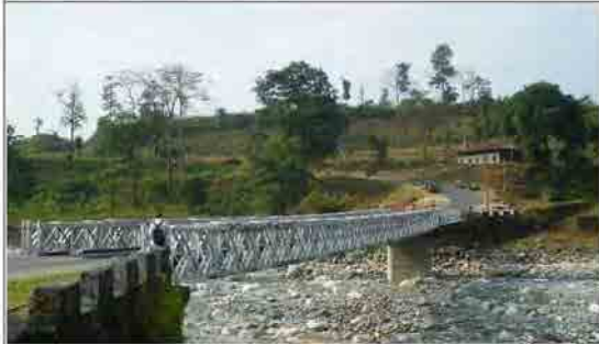
写真3: ジグミリング橋の全景
