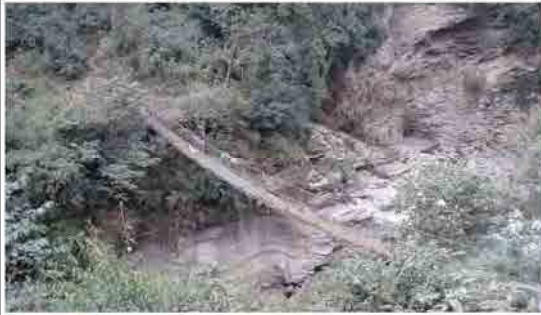
写真 9：ジャンビ橋の全景
