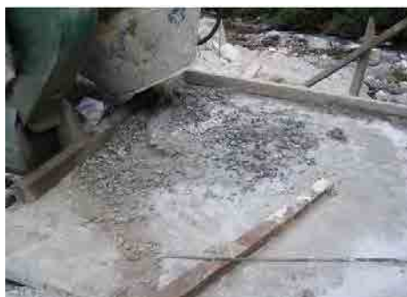
写真-機材保管状況 清掃がされていない
