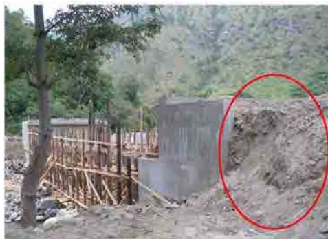
写真-埋戻状況 転圧不備(監理不足)
