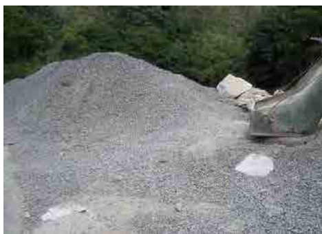
写真-骨材保管状況 整理がされていない
