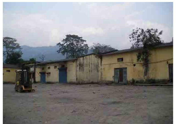
写真-通関地状況-2
