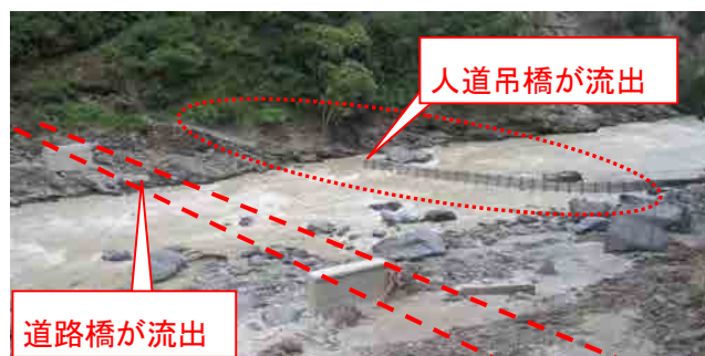
写真-サイクロン・アイラにより被災した橋梁
