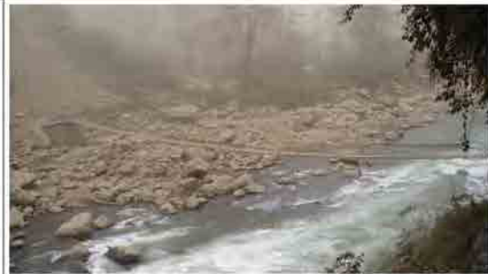
写真5: マンデチュ(レオタラ)橋の全景
