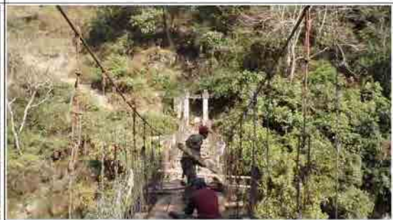
写真8: ケラ橋 床版は木製で所々破損がある。作業員による床版補修状況。
