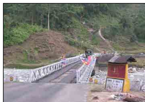
写真-既設ベイリー橋
