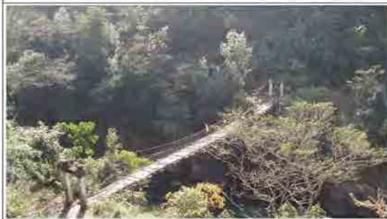
写真7: ケラ橋の全景
