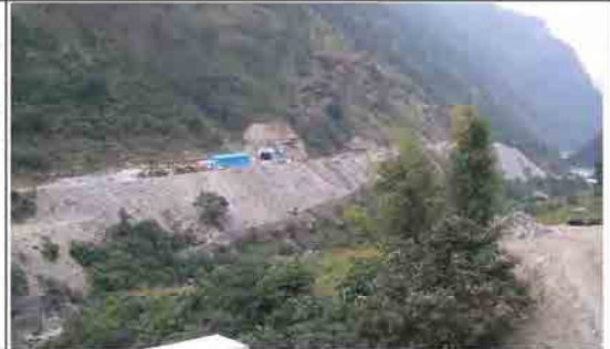
写真 14：国道 5 号線でのプナチャンチュ水力発電関連工事の状況。
