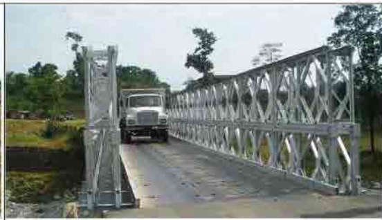
写真2: ドルコラ橋 徐行しながらのトラック渡橋状況
