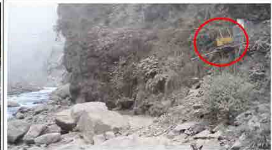
写真6: マンデチュ(レオタラ)橋 洪水時はケーブル高まで冠水
