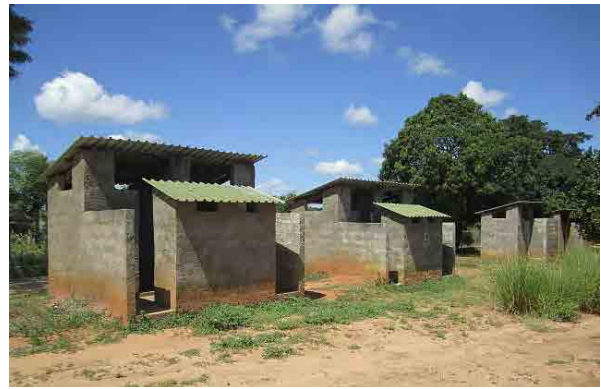
ES de Muecate: 州内の多くの学校が貯留式(「ラトリン」)の簡易な便所を設置している。
