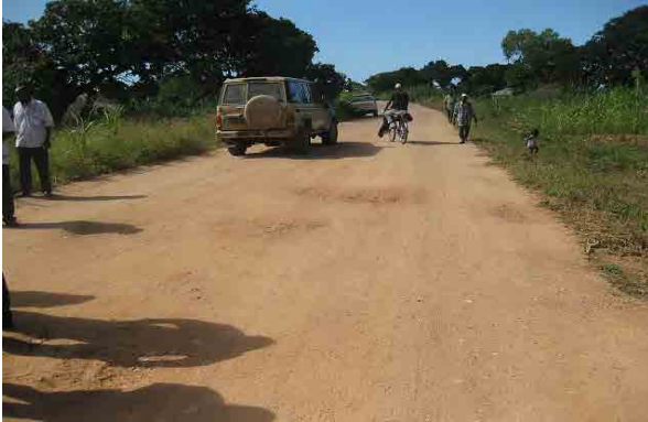
メンバ中心部からのアプローチ道路。未舗装で雨期は工事車両の通行が困難となる。
