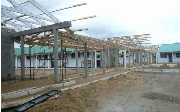
Gaza 州 Manjakaze: 渡り廊下施工中の状況。
