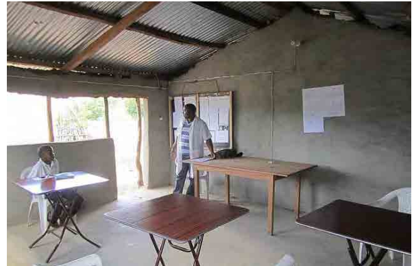
ES de Meconta: 教室以外の施設を欠き、自力建設の仮設建物を教員室としている。
