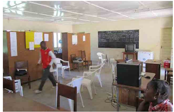
ES de Memba: 近年建設された管理棟内部。PC・複写機等は学校運営に不可欠で、施錠できる室が必須。
