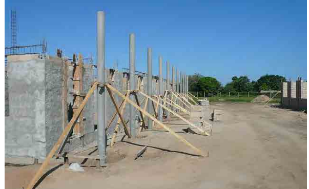
Matola 市 Cobe: 教室棟躯体施工状況。
