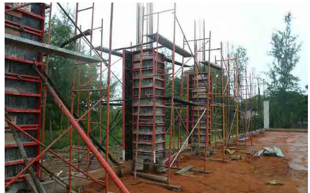
Gaza 州 Chissano: 簡易体育館独立柱の施工中の状況。
