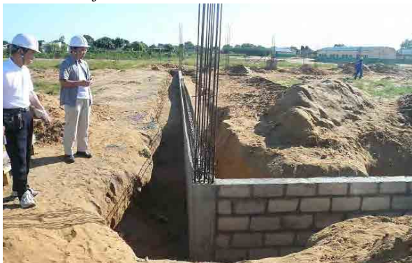
Matola 市 Congolote: 基礎工事中の状況。
