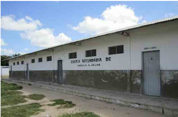
ES de Nacala-a-Velha: 小学校施設を転用して2006年に開校。施設の状況は比較的良好である。
