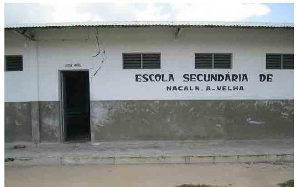
ES de Nacala-a-Velha: 組積造の外壁に大きなクラックが走っている。
