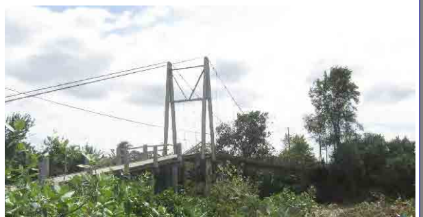
No.43 TAM NGAN BRIDGE
