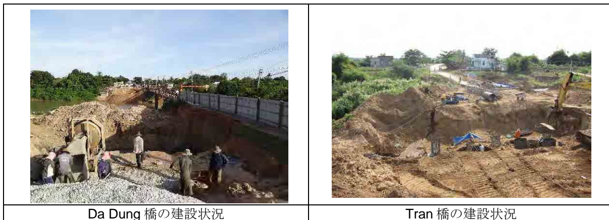
写真－6 他ドナー等が実施した橋梁および第一次中部地方橋梁改修計画で完成した橋梁
