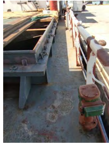
上甲板中央部 腐食が激しい
