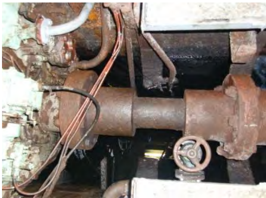
中間軸、フランジ継手が腐食 ビルジが溜まっている 船底構造材が腐食
