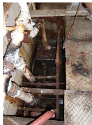
機関室配管に錆び
