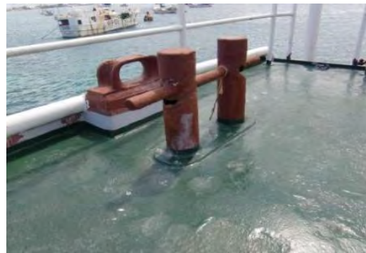
ビットに腐食の大穴
