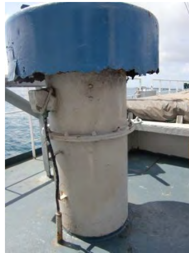
錆びた通風機
