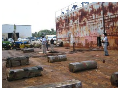
腐食が激しくいたるところに穴
