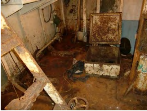
階段ステップは錆びで欠落
