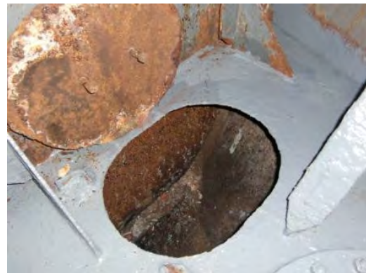
マンホールカバーの腐食が顕著
