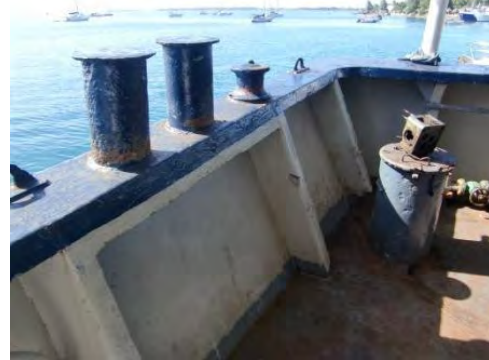
係船ビット腐食顕著
