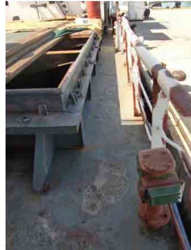
上甲板中央部 腐食が激しい
