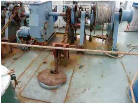
錆が多い揚錨機まわり
