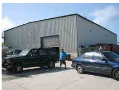
資材倉庫外景
