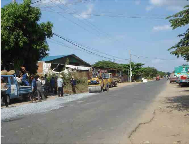
Sta. 1+800 付近 「カ」国側による路面 補修作業
