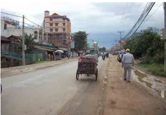
Sta. 0+900 付近 路肩、雨水滞水状況
