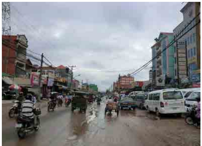
Sta. 0+500 付近 交通状況と路面状態
