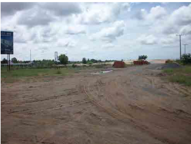
Sta. 3+100 付近 チョーライ・プノンペン病院 建設予定地
