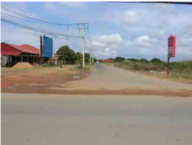
Sta. 2+300 付近 取付け道路及び 排水水路流末予定地
