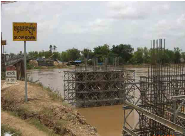
国道 11 号線の整備状況
