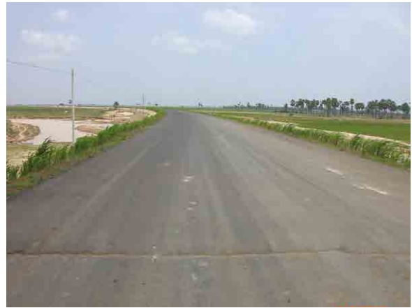
国道 8 号線の整備状況
