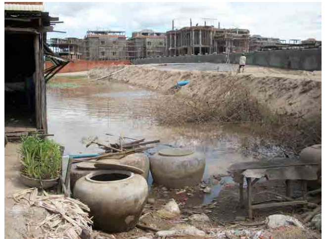
Sta. 2+650 付近 沿道の開発による埋立て、 盛土状況
