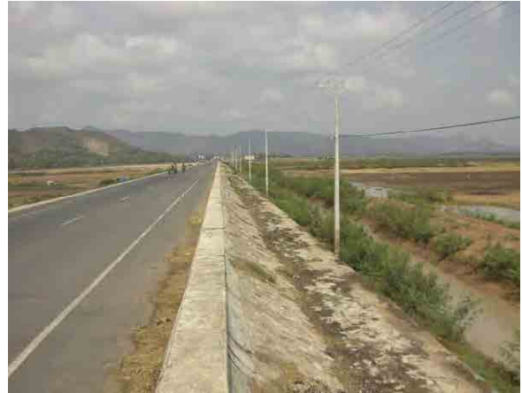
国道 2 号線の整備状況
