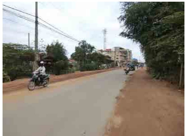
Sta. 3+700 付近 路面、路肩状況
