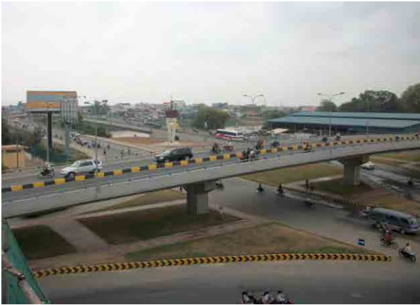
新旧モニボン橋（奥）とプノンペン側の新立体交差点
