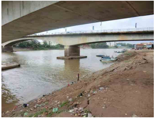
Sta. 0+000 モニボン橋桁下 排水路流末予定箇所
