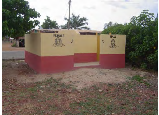
既存CHPS施設(Dobile)に併設されたトイレ棟。出入口が男女別になっており、絵で示されている。
