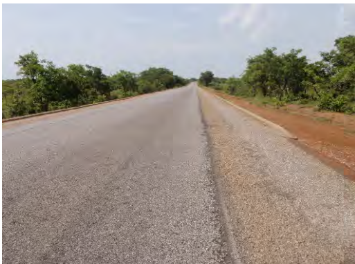
サイトへ至る幹線道路。一部の幹線道路は舗装されている。(No.701Tanina)
