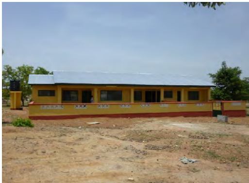
郡議会により建設されたCHPS施設。塀が低いため、住居部分も室内が見える。(No. 804 Sing)
