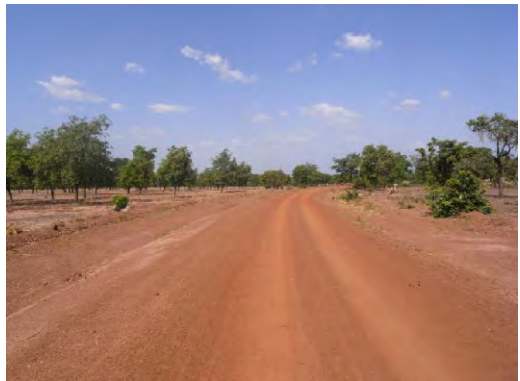
サイトへ至る道路。舗装されていないが、土質が良いため雨季の通行も大きな支障はない。(No.606 Konchuri)
