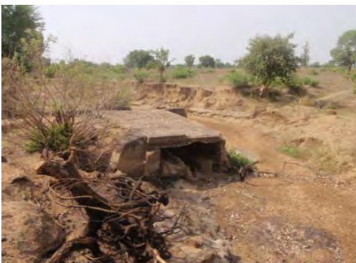
サイトへ至る渡河地点。乾季は水が引いて通行可能である。(No.903 Tegme-Tuole)
