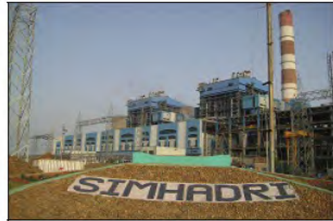
シマドリ火力発電所
