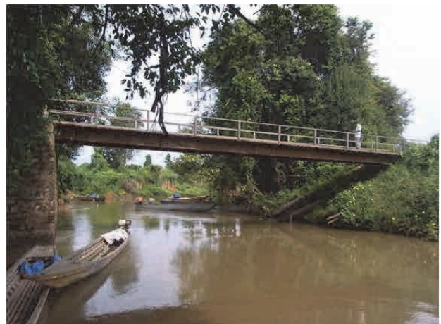
アンドメア郡：仮設橋新設工事
