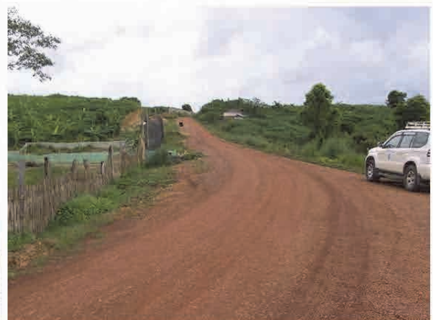
モンドルギリ州カオシマ郡既存未舗装道路一部区間のラテライト舗装工事
