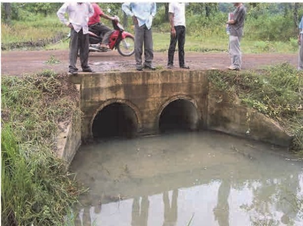
コンモン郡国道 78 号線とコンミューンをつなぐ未舗装道路上の橋梁建設及びパイプカルバート設置工事
