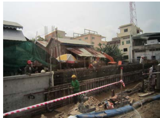
民家と接近した作業
