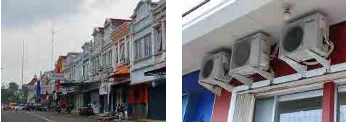
図 2.5.4-10 代表的商業施設の形態である Ruko の外観とエアコンの設置状況
