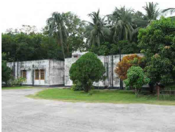
写真-5 既存の管理事務所
