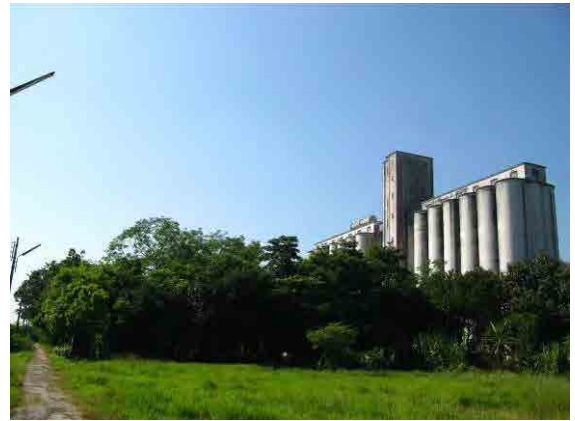
写真-4 建設予定地
