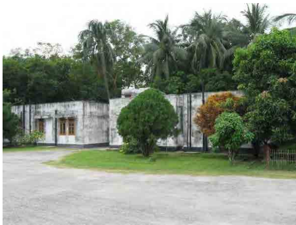
写真-5 既存の管理事務所
