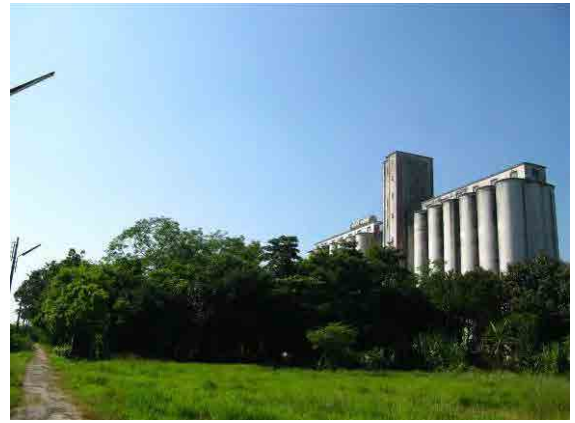
写真-4 建設予定地
