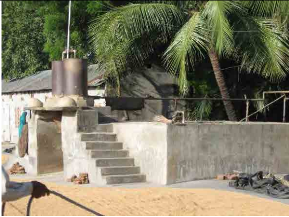
写真-7 小規模精米業者の施設 パーボイル処理、天日乾燥、精米を行う。水槽、蒸煮設備、ドライヤード等から構成される。
