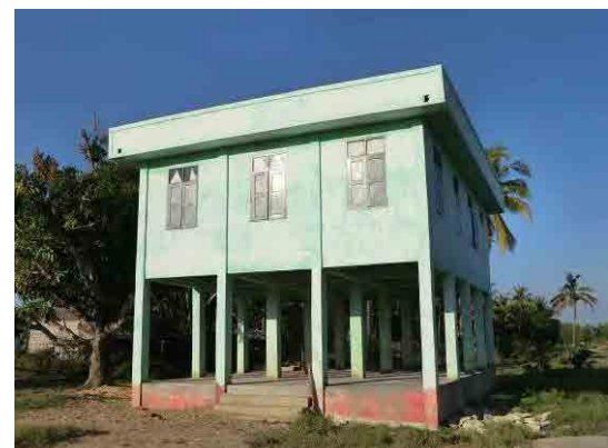
写真-12 サイクロン避難施設 プロジェクトサイトで確認された、写真-11とは異なる形状のサイクロン避難施設。トイレ、給水設備はない。
