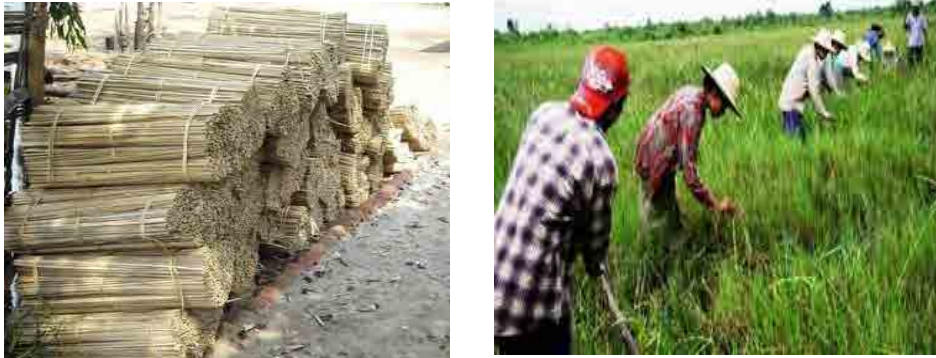
図 3.10 杭打ちの竹 (左) と杭打ちの様子
