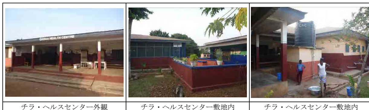
写真：チラ・ヘルスセンターの様子
