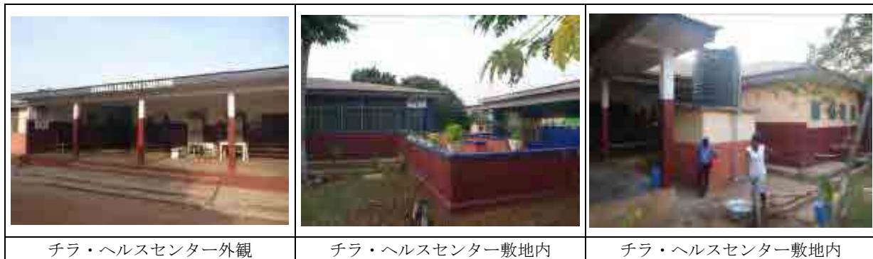
写真：チラ・ヘルスセンターの様子
