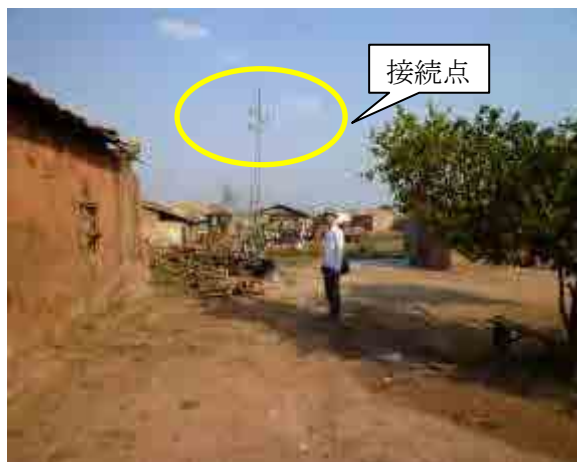
11.5kV 配電線接続地点の様子
