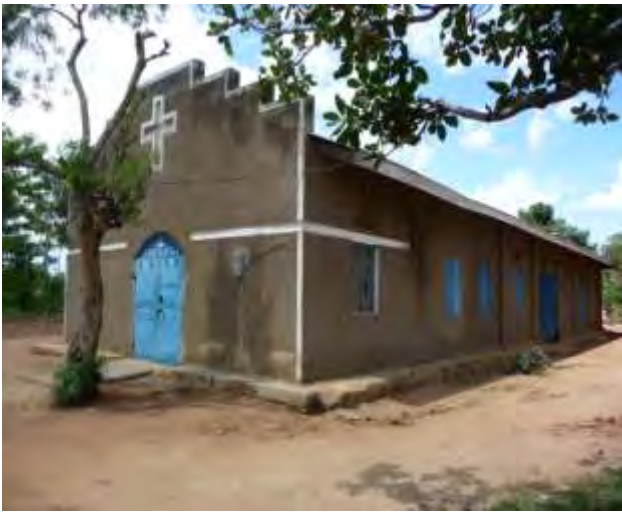
① ナムンガルウェの教会では内部配線が完了し低圧配電線が引込まれていた。
