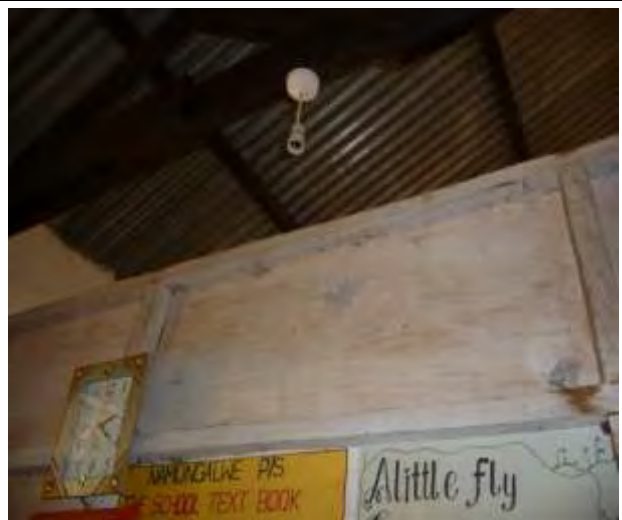
⑤ ナムンガルウェの小学校の校長室の内部配線も完了していた。
