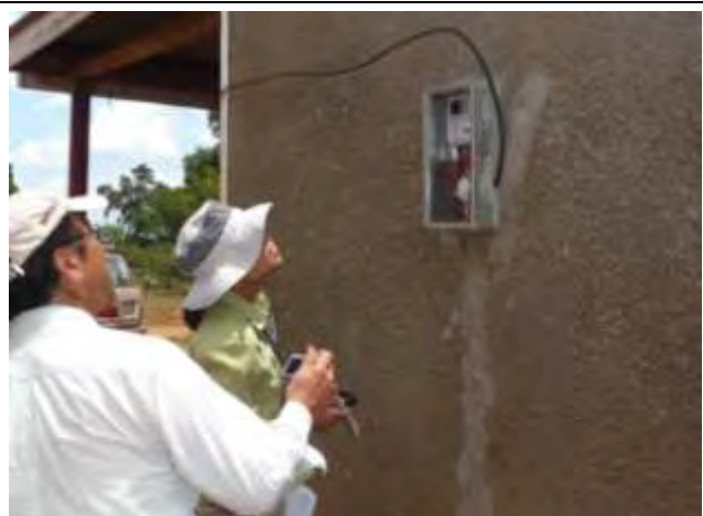
⑨ 50 軒程度の住宅は接続されていた。需要家用電力量計の保管箱が設置されているものの接続待ちの住宅は 30 件程度である。
