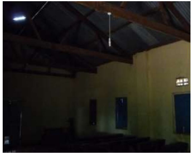
② ナムンガルウェの教会内部の蛍光灯
