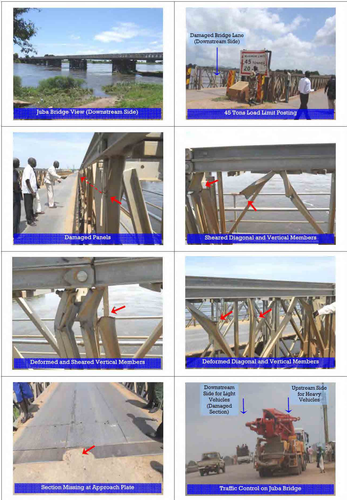
写真 2-2-1 ジュバ橋の損傷状況と走行制限
