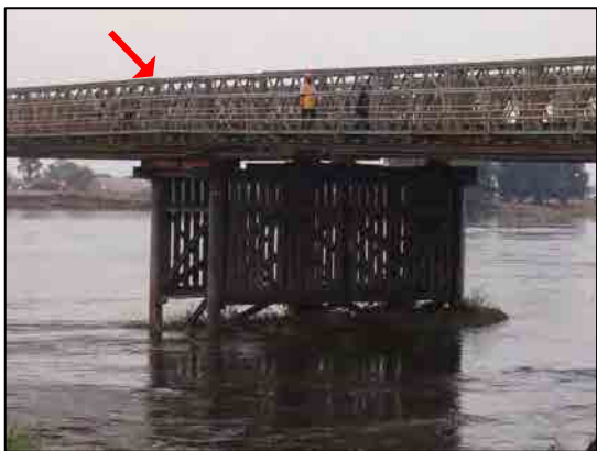
ジュバ橋梁の修復部材位置
