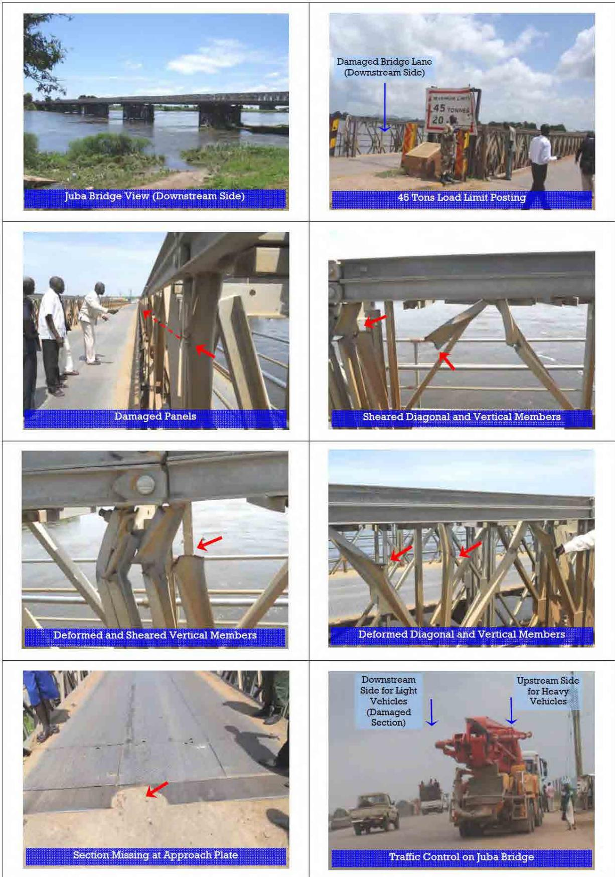
写真 2-2-1 ジュバ橋の損傷状況と走行制限
