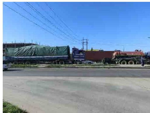
ニエレレ道路を横断する高圧線（移設を要する）
