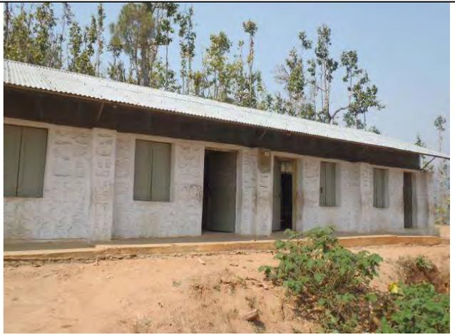
写真-10 同左(既存棟) 既存教室棟は天井高さが不十分で、採光、換気が悪いため無償資金協力による教室棟のほうが学習環境がよいという評価であった。既存棟は構造的にも脆弱である。
