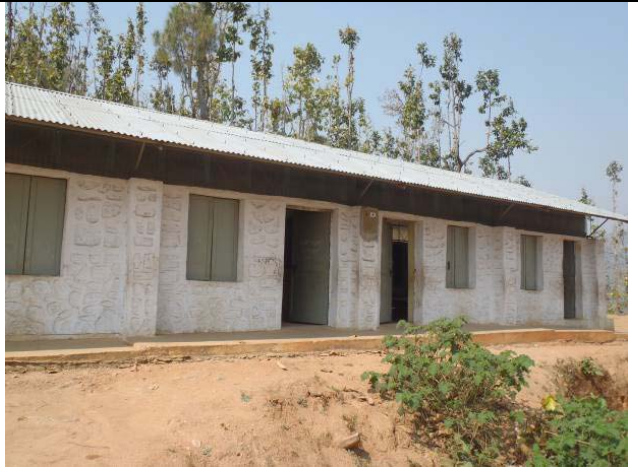
写真-9 Indrayani LSS(Gairi Bhanjyang, ダディン郡) 教室棟及び便所棟(2005年及び2008年無償資金協力)それぞれ、既存教室を中心として敷地の造成を繰り返しつつ、拡張を行っている。
