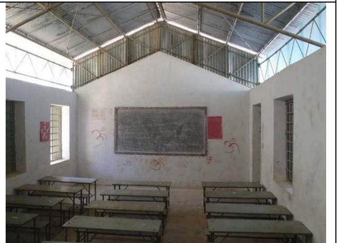
写真-12 同左 教室棟は側面の明り取りによって内部は採光が十分である。調達された家具は組み立てられて教室内に配置されている。
