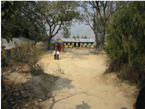
視察した小学校④（地方部小規模校） 〔ネパール〕 校舎
