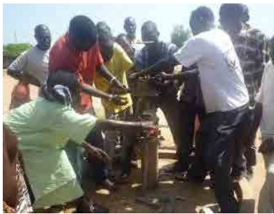
井戸ポンプの改修
