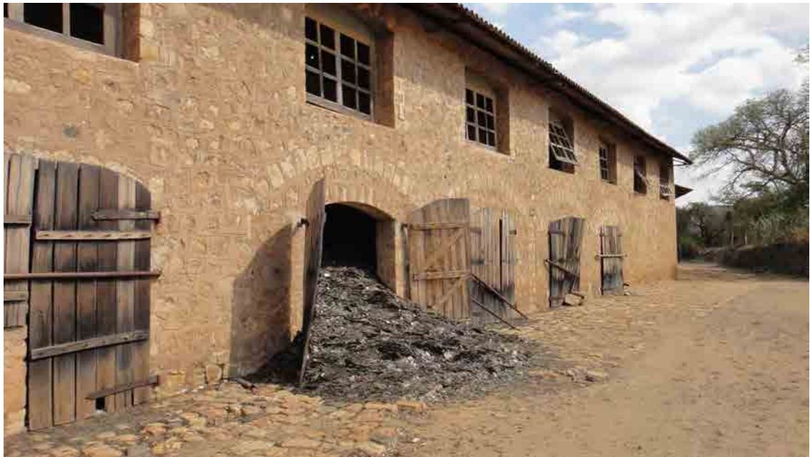
Photo 2 Phlogopite débordant d'un entrepôt
