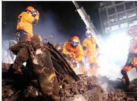
瓦礫除去のためエンジンカッターで鉄筋を切る救助隊員
