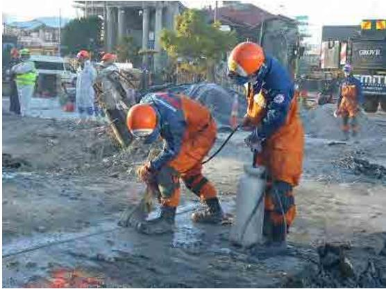
ダブルブレードカッターでコンクリート破砕する救助隊員
