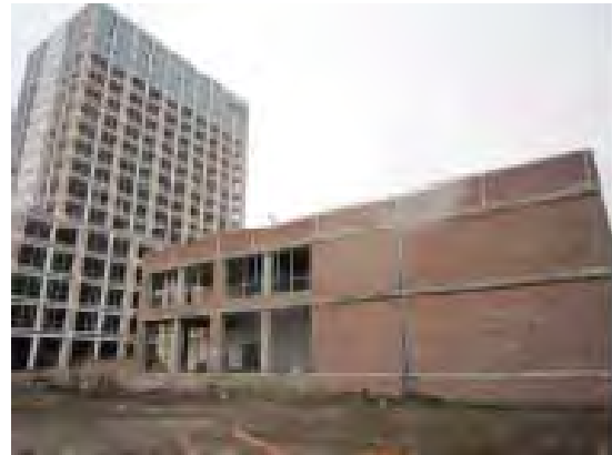
写真-2：GDVC 新庁舎事務棟建設現況（2011年12月8日撮影）
