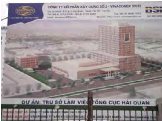
写真-1：GDVC 新庁舎建設現場標識（完成予想図）。左奥がデータセンター棟（5階建）。
