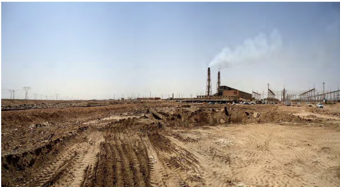
写真 4 - 2 Nasiryah II project site 2
