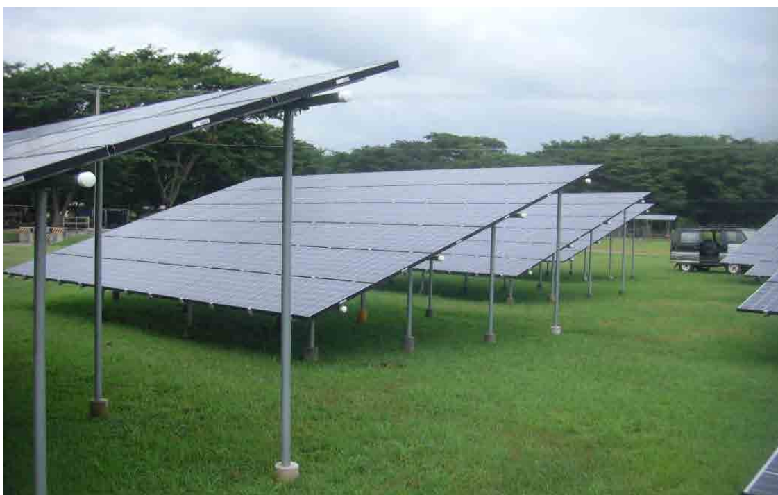
Figura 4.4.4 Sistema fotovoltaico instalado en el campamento base de EE. UU. (91 kW)
