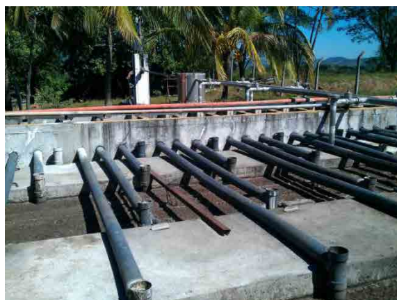
図4.8.7 上向流式嫌気性汚泥ブランケット
