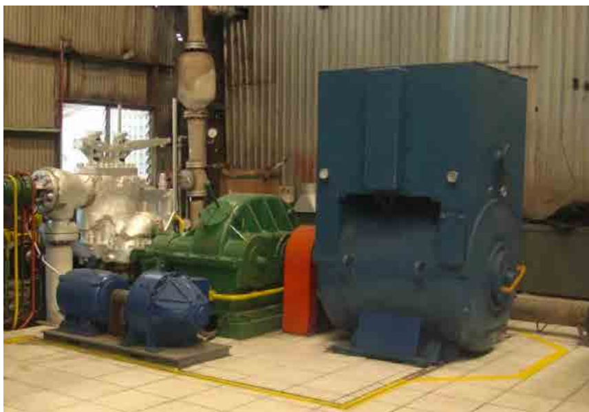
図4.7.3 蒸気タービン発電機
