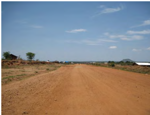
ジュバ市内環状道路 (C3) (補修された土道)
