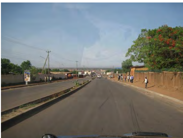
舗装されたジュバ市内環状道路 (C1) (市内道路のうち約65kmが舗装済/実施中)
