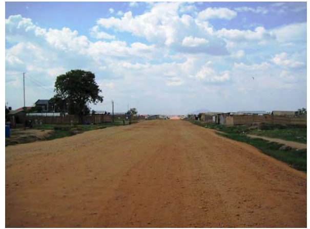
M/Pパイロット事業で整備されたフィダー道路 (排水工も整備され道路状況は良好)
