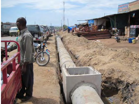
ジュバ市内放射道路（R6） （排水工が整備されるが、流末が未整備）
