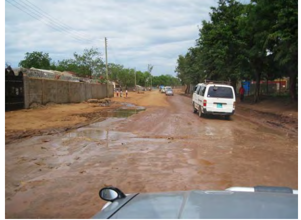
ジュバ市内コレクター道路 (排水不良により損傷する道路)
