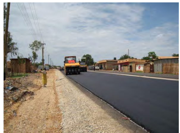
舗装工事の状況 (放射道路R3) (南部スーダン政府の民間委託にて実施)
