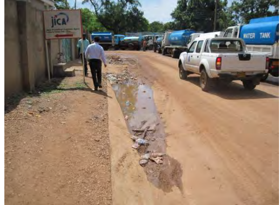
図 3-4 排水不良の道路
