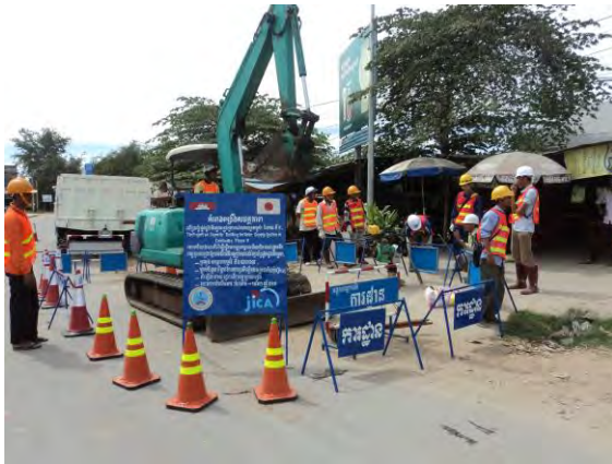
配水管布設研修 (OJT)
