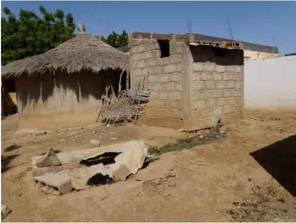
Celing 村 トイレの外観② (右奥) と排水槽 (左手前)
