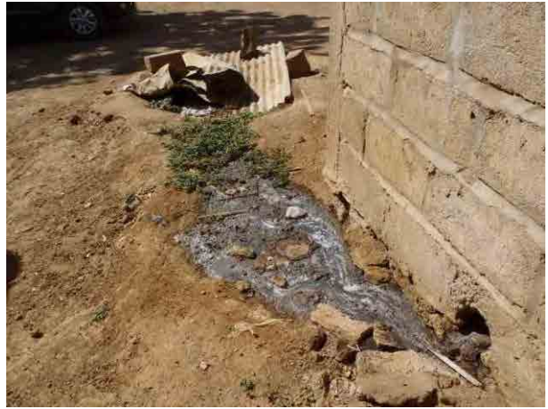
Celing 村 トイレからの排水状況
