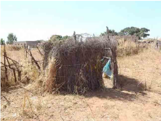
Guilobe 村 世帯用トイレの外観
