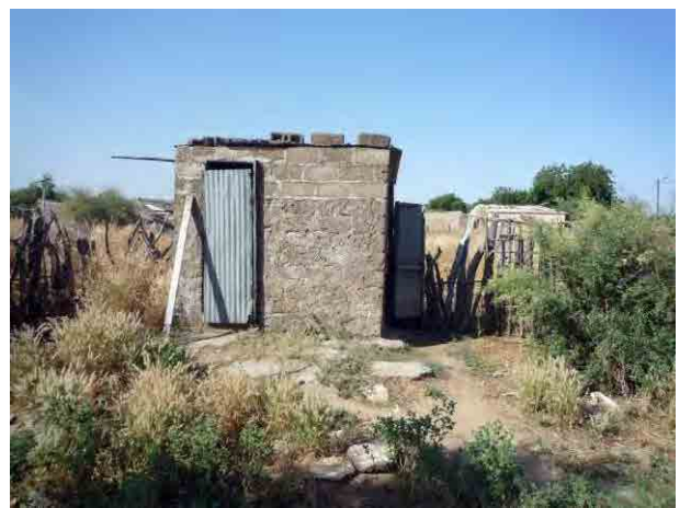
Celing 村 トイレの外観①
